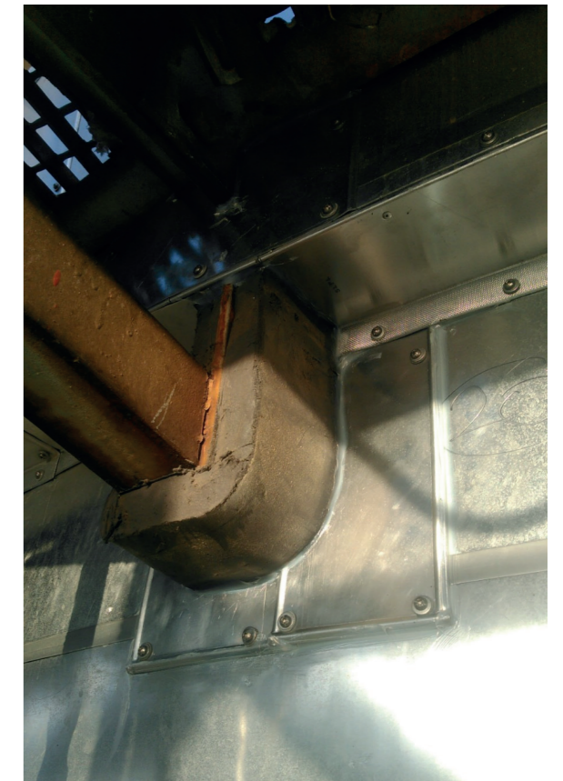
Chabel Thermo Protect als afdichting op stalen balk
